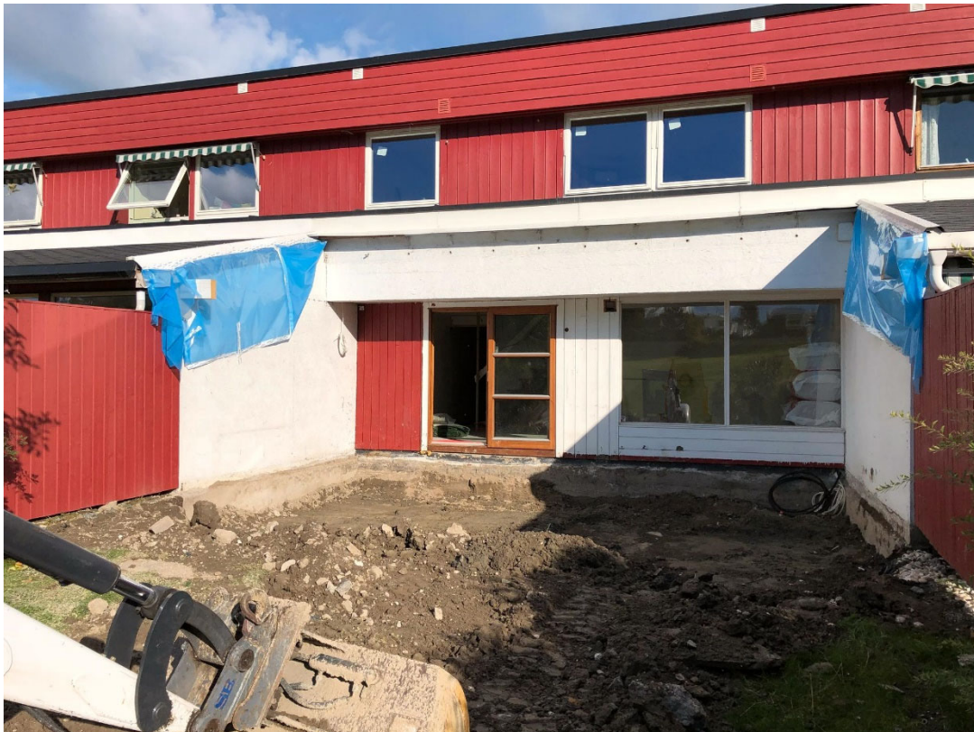
Det ble mye graving for å få et nytt rom med raus takhøyde. Foto: Privat
